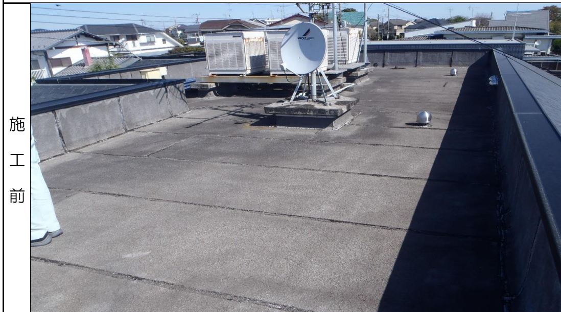
施工現場全景
