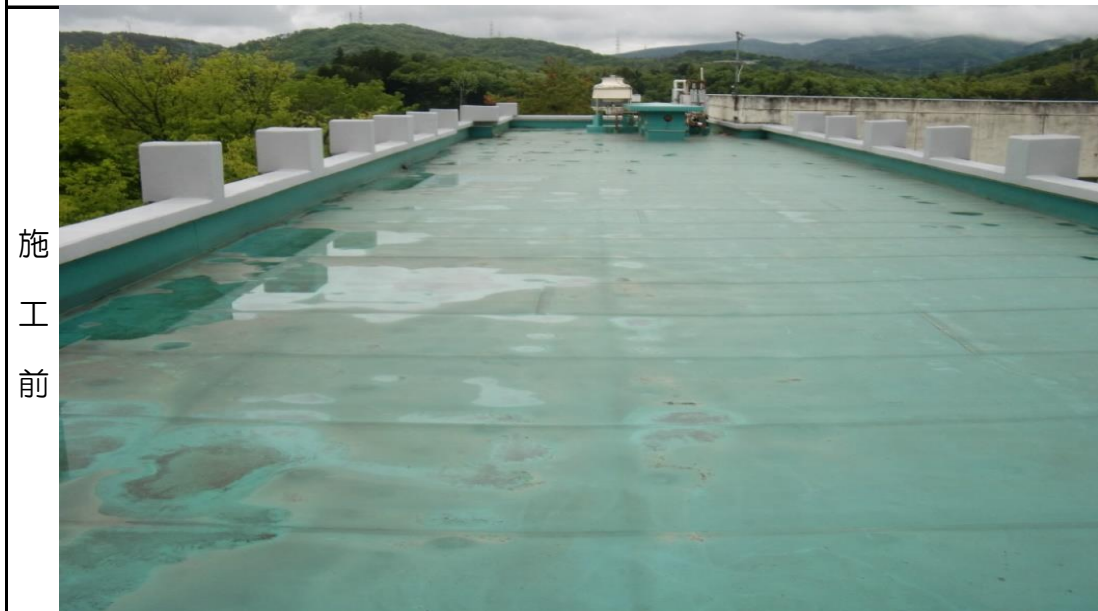
施工現場全景
