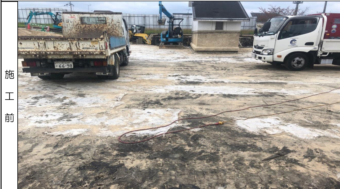
施工現場全景
