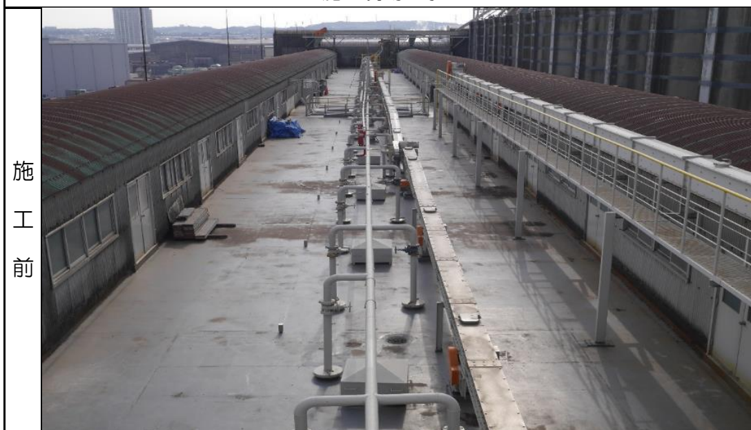
施工現場全景
